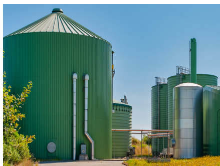
Obloga biogas postrojenja
